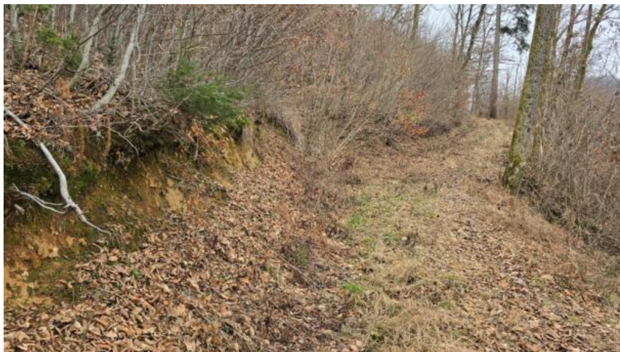
Slika 1: Gozdna cesta nad obravnavanim območje. Vkop je v celoti izveden v svetlo rjavo preperinsko glino
